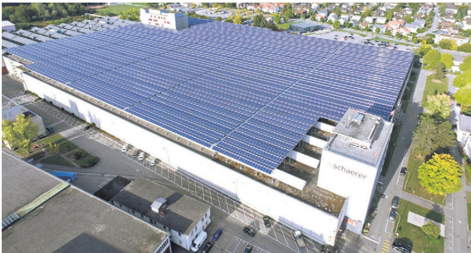
Die Photovoltaikanlage der Helion Solar AG auf dem Riverside Areal in Zuchwil SO ist mit einer Leistung von 5,7 Megawatt eine der leistungsstärksten Solaranlagen der Schweiz.
