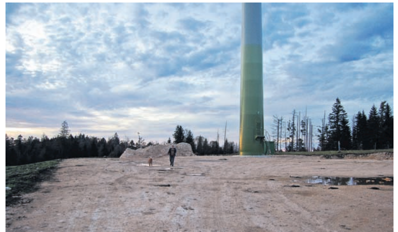
Saint-Bras: Jede Windturbine benötigt zerstörerische Infrastrukturen. Trostloser Anblick dieser Baustellen, die inmitten schönster Natur errichtet werden...
