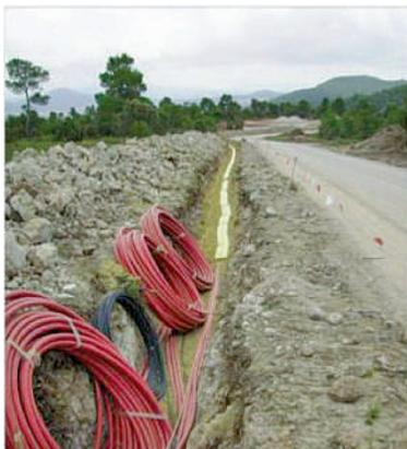
Erste brutale Einschnitte: Kabelverlegung in werdendem Windturbinenkomplex.
