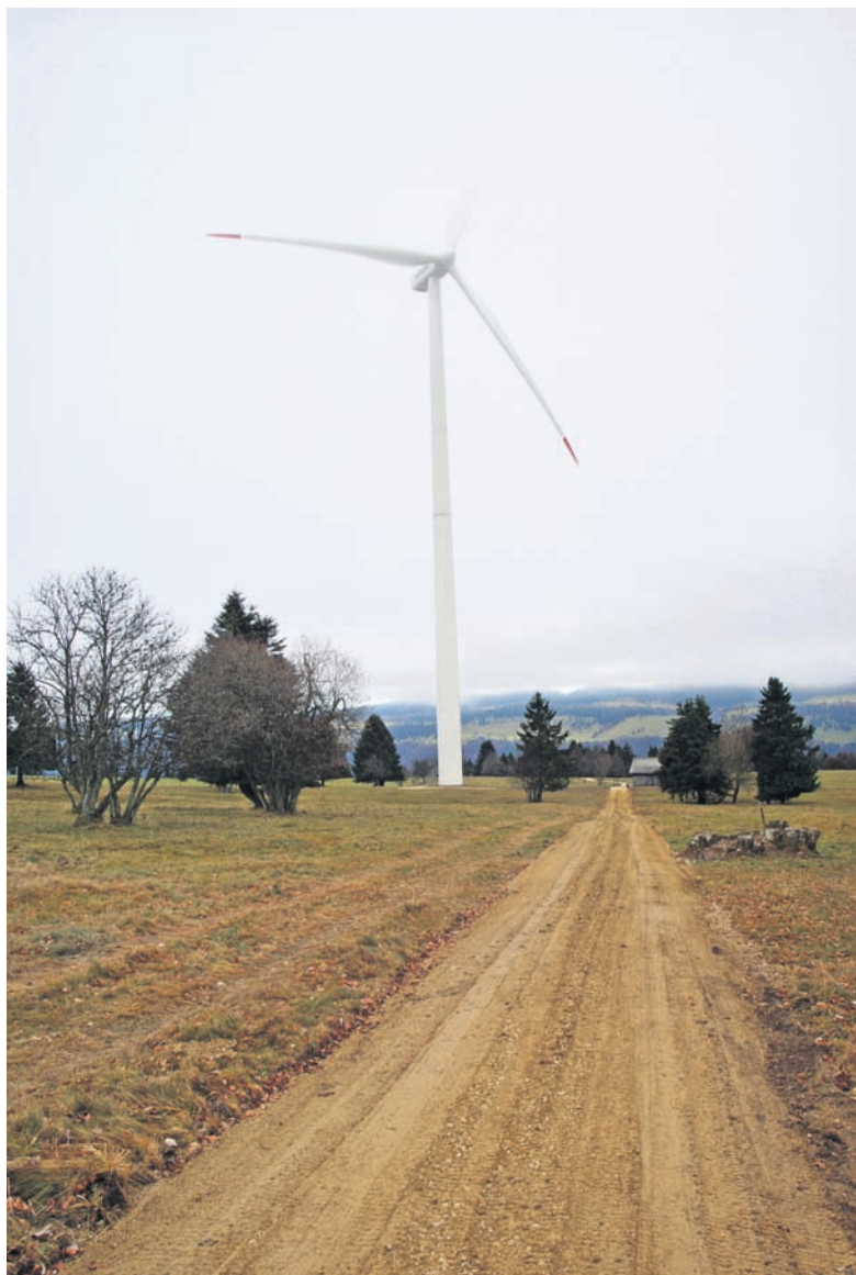
Construction, activité et entretien des éoliennes nécessitent des accès qui portent atteinte à ce paysage sensible.
