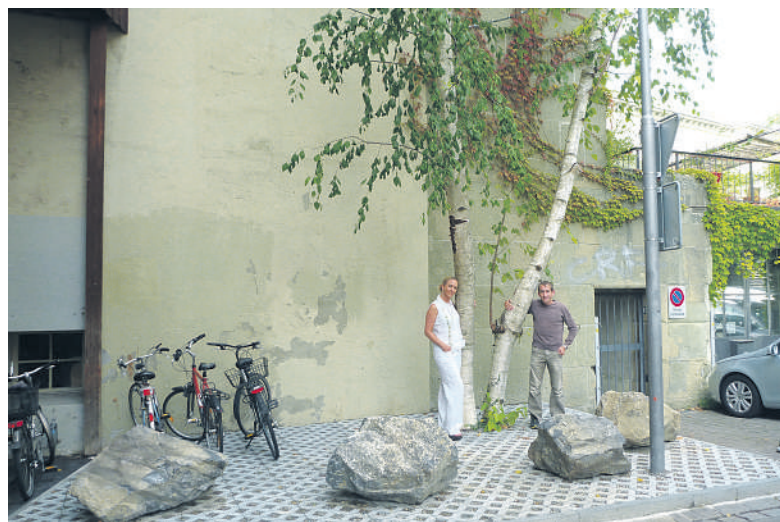
Les racines du bouleau et une grille en béton qui laissera passer l'eau et l'air, assurent désormais la protection contre l'érosion.
