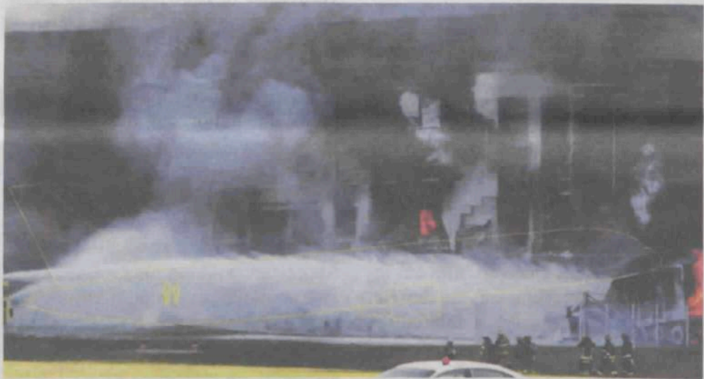
Das Pentagon kurz nach dem Einschlag: Das Dach ist noch intakt, es gibt nur ein etwa 5 m breites Loch und einige Fasadenschäden. Zum Grössenvergleich eingezeichnet ist eine Boeing 757: 47 m lang, Spannweite 38 m, Rumpfdurchmesser 4 m, Durchmesser der Düsen je 2,75 m, Materialmasse 60 t.
