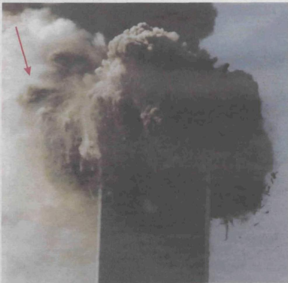
Un exemple de l'apparence symétrique, ressemblant à un champignon, du nuage de poussière et de débris qui s'est échappé de façon égale de tous les côtés de la tour. La flèche rouge montre à quelle distance les débris ont été projetés horizontalement à l'extérieur, à cent mètres pour quelques uns. La tour elle-même n'est large que de 63 mètres.
