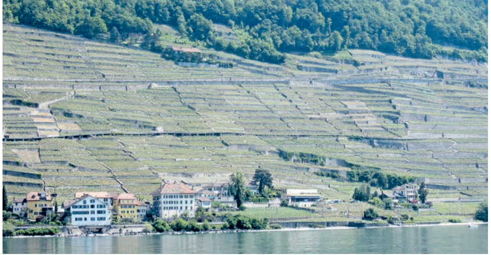
Un énorme projet de construction est prévu à Treytorrens dans le Dezaley. Helvetia Nostra et Sauver Lavaux ont déposé un recours auprès du Tribunal fédéral contre ce projet scandaleux, qui menace la protection de Lavaux, inscrit au patrimoine mondial de l'UNESCO. (Photo Suzanne Debluë)
