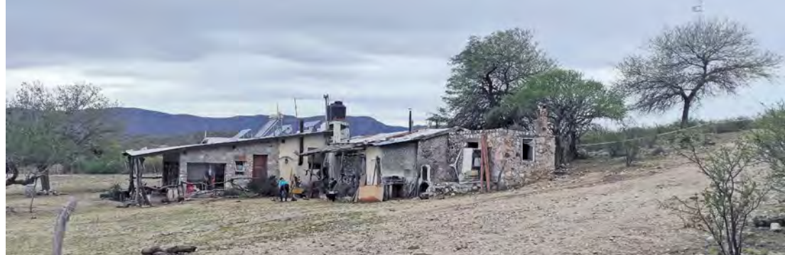
Das Hauptgebäude auf Equidad, wo noch Einiges an Arbeit anfallen wird.
