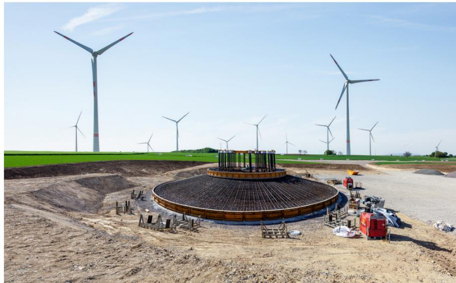
Zur Stabilisierung der Statik werden pro Windturbinen-Turm bis zu 10'000 Tonnen Beton als Fundament im Boden versenkt. Je nach Standort und Untergrund muss bis zu zwölf Meter tief gebohrt und verankert werden. Die Eingriffsfläche beträgt 4'000 Quadratmeter pro Anlage, dabei werden 500 Quadratmeter Landwirtschafts- oder Waldfläche ein für allemal vollversiegelt; an einen Rückbau ist realistischlicherweise kaum mehr zu denken.
