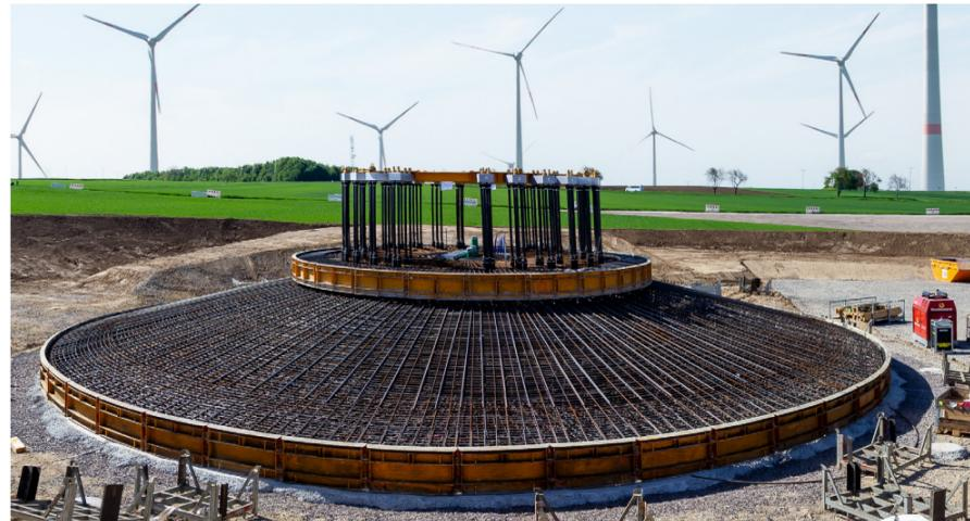
Jusqu'à 10'000 tonnes de béton sont enfoncées dans le sol pour servir de fondation à chaque éolienne. Selon le site et le sous-sol, il faut forer et ancrer jusqu'à douze mètres de profondeur. La surface d'intervention s'élève à 4'000 mètres carrés par éolienne, et 500 mètres carrés de surface agricole ou forestière sont une fois pour toutes entièrement scellés ; un démantèlement n'est pratiquement plus envisageable. Source : iStock
