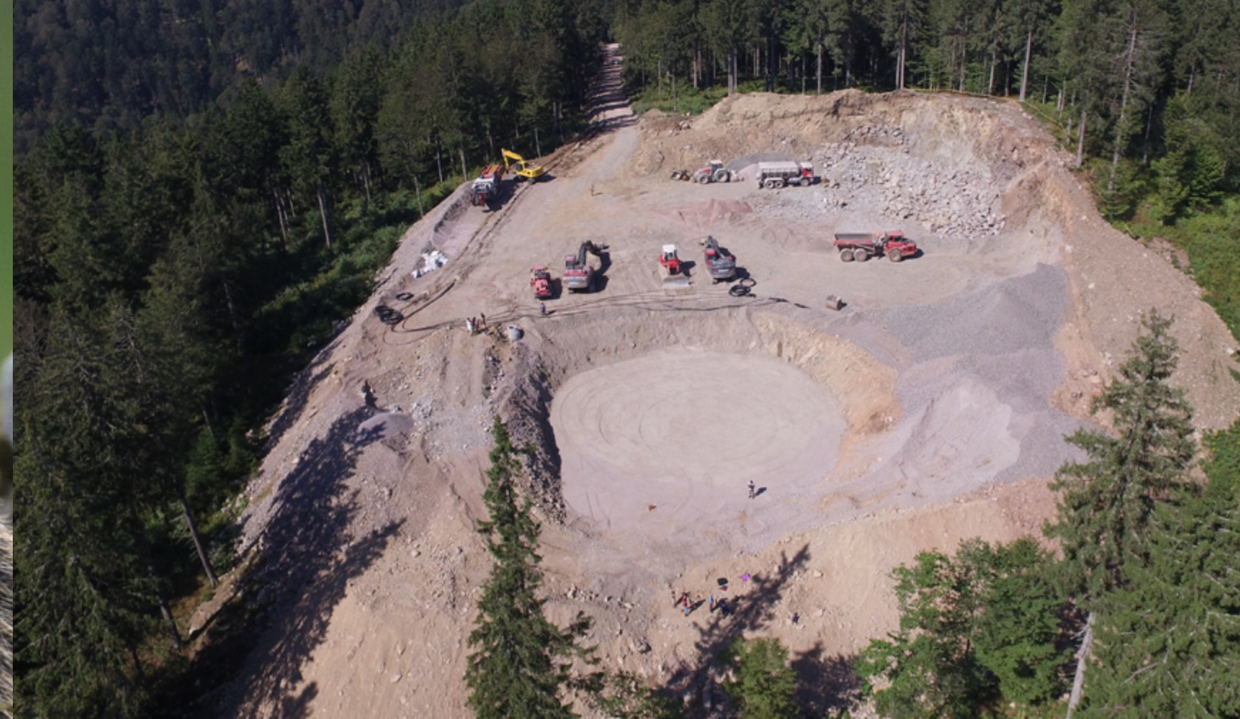
Construction du parc éolien de Gersbach en Forêt-Noire, Allemagne
