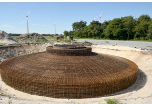
Des tonnes d'acier et de béton pour la construction d'éoliennes en pleine nature
