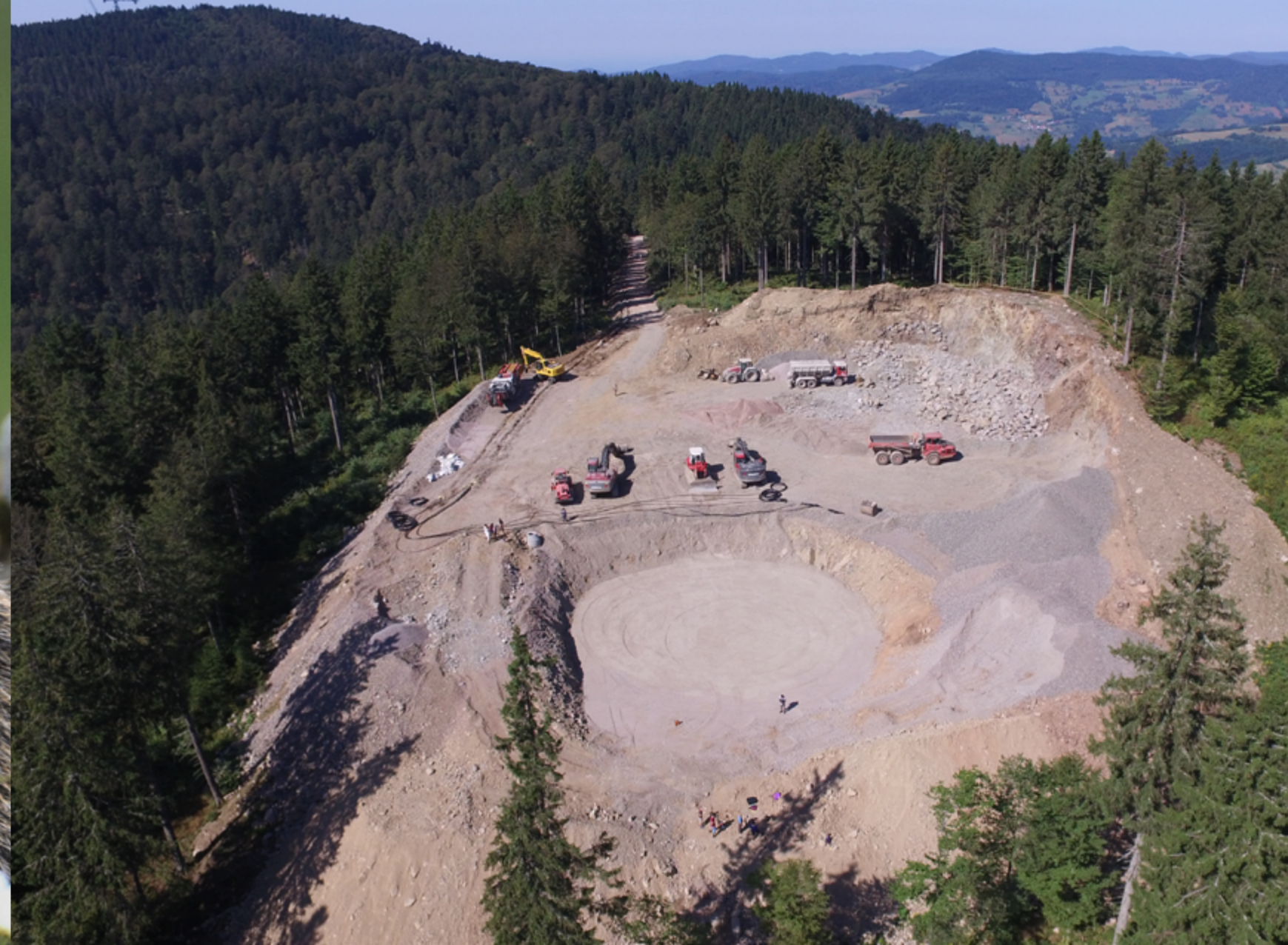
Bau vom Windpark Gersbach im Schwarzwald, Deutschland
