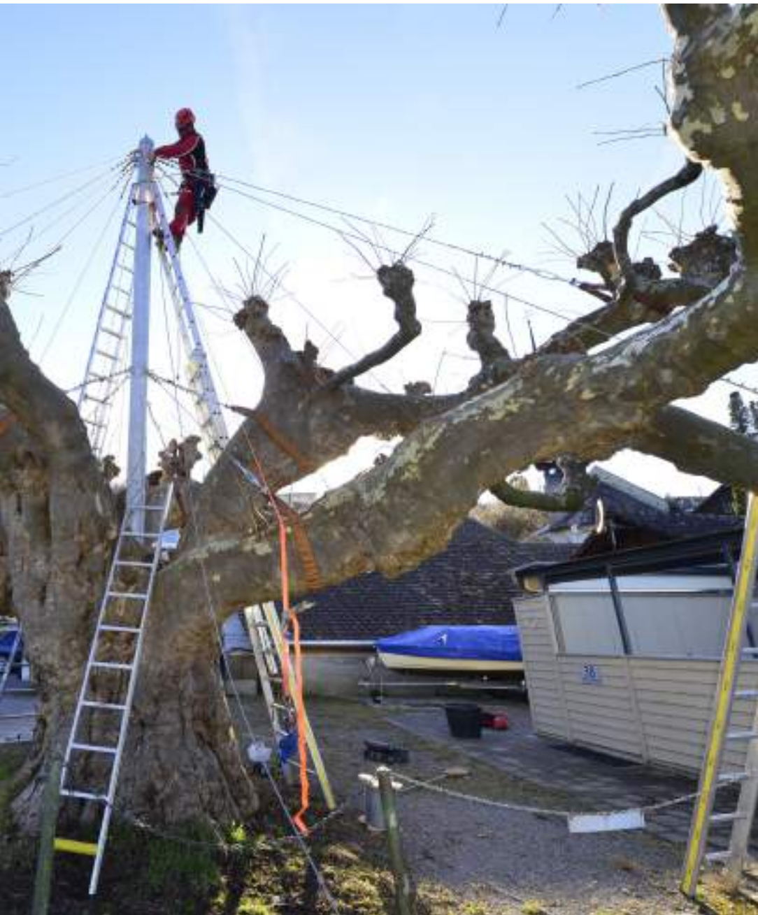
Mit acht Meter Länge und 800 kg Gewicht ist der angelieferte Eisenpfahl eine eindruckliche Konstruktion. Nach dem Laubaustrieb wird die Stahlkonstruktion mehrheitlich im Kronendach der Platane verschwinden.
