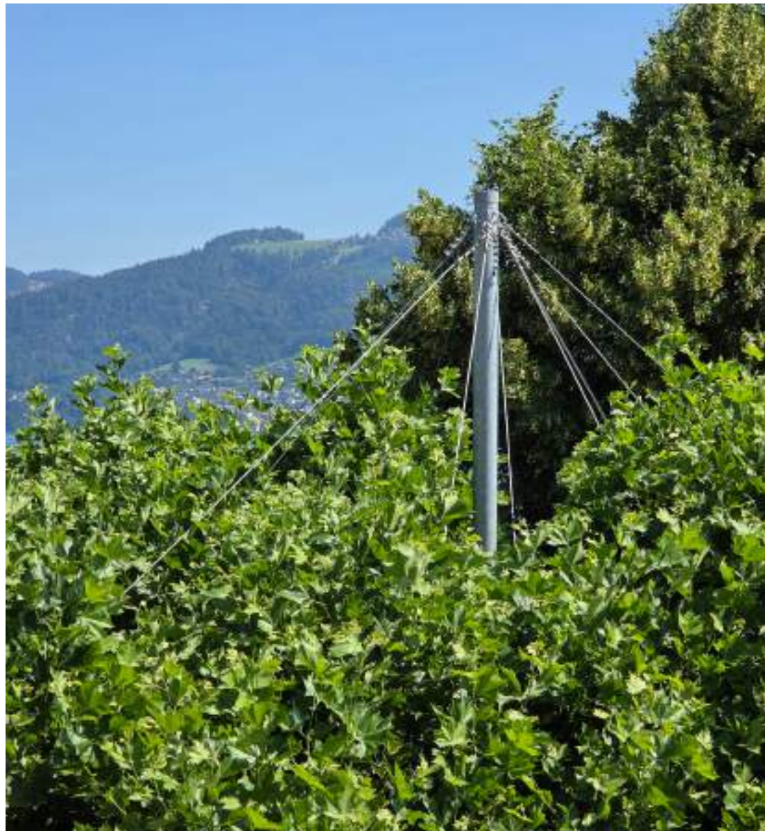
Nebst der neuartigen Stützkonstruktion, die an ein Schirmgestell erinnert, wurde die Platane in der äusseren Kronenperipherie entlastet.
