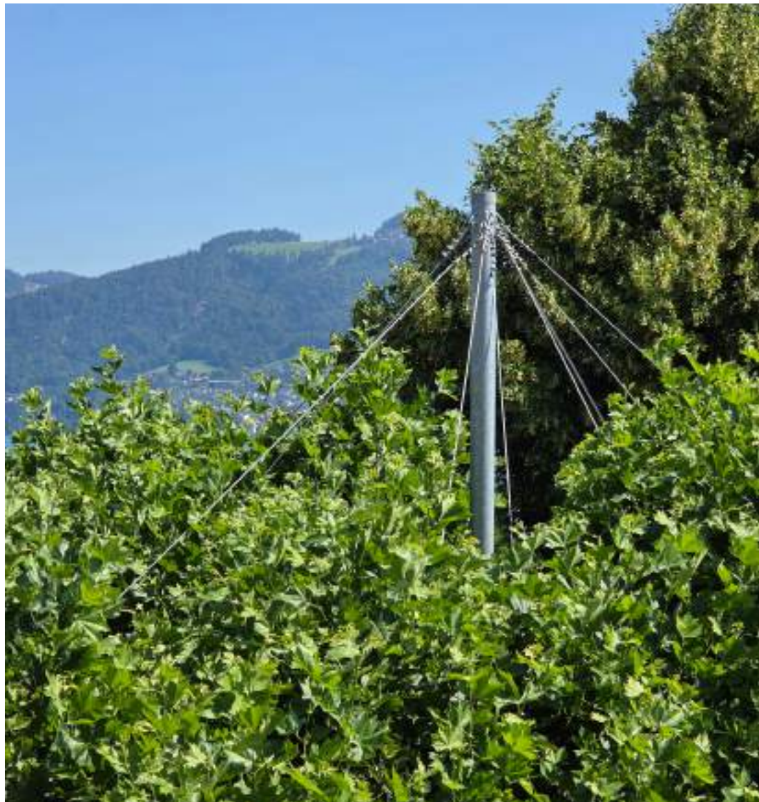
Outre la mise en place du dispositif de soutien inédit, qui évoque l'armature d'un parasol, la périphérie extérieure de la couronne du platane a été allégée.
