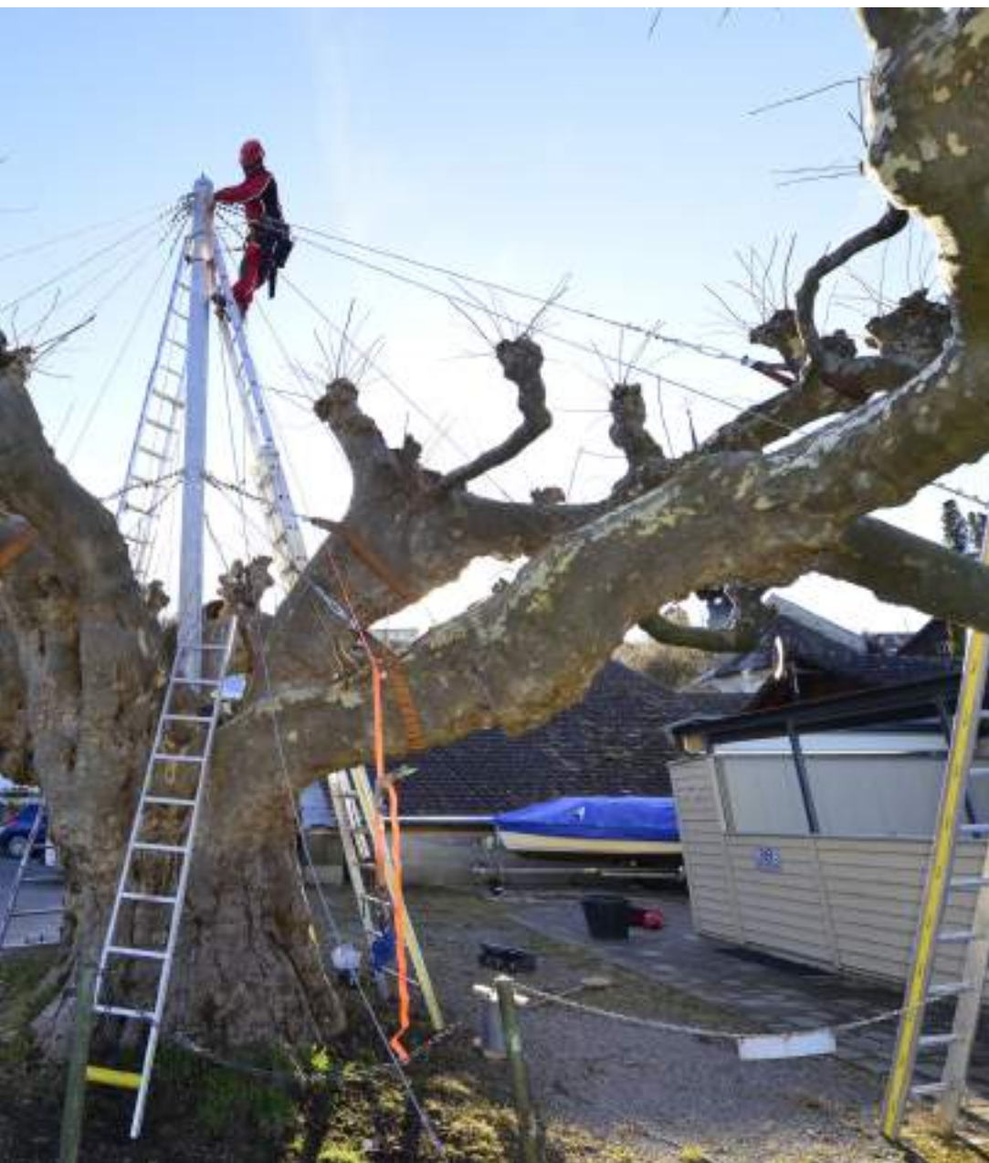
Avec ses huit mètres de long et ses 800 kilos, le mât métallique livré sur place est une construction impressionnante. Après l'apparition des feuilles, la structure métallique disparaîtra en grande partie dans la couronne du platane. Photos : Michel Brunner
